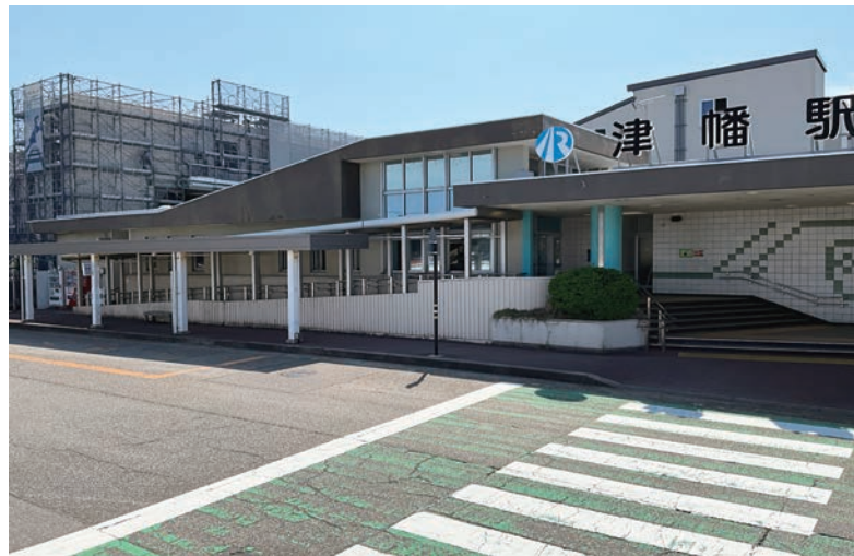
津幡駅の利便性アップ（左上は建設中の東西自由通路）
