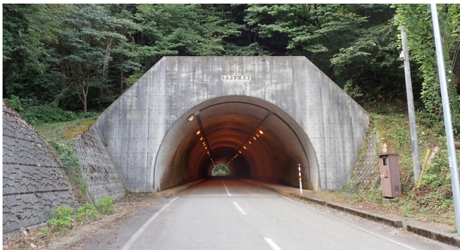
写真1 下中トンネル全景
