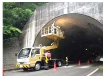
写真2 トンネル点検状況
