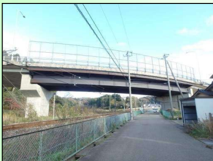
清水跨線橋 橋長：140.00m 昭和 63 年架設
