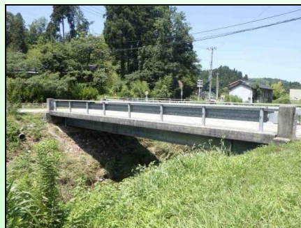
下藤又橋 橋長：14.60m 昭和 41 年架設
