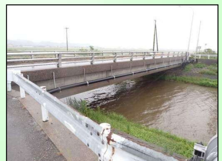
浦能瀬大橋 橋長：30.70m 昭和 52 年架設
