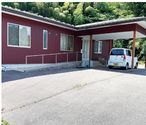
休業中の介護施設
