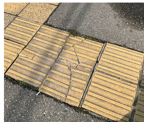
傷みが目立つ点字ブロック
