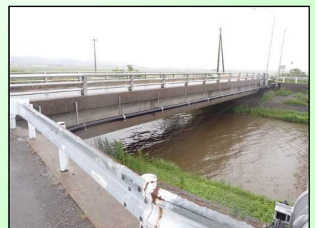
浦能瀬大橋 橋長：30.70m 昭和 52 年架設
