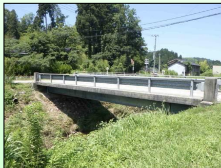
下藤又橋 橋長：14.60m 昭和 41 年架設
