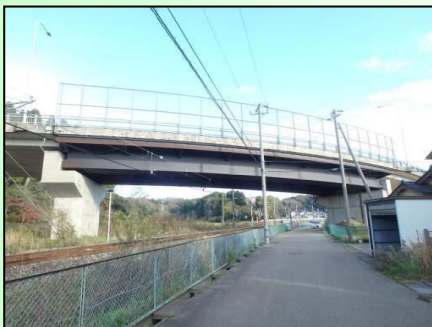
清水跨線橋 橋長：140.00m 昭和 63 年架設
