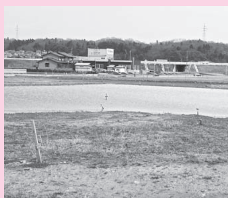
現在、急ピッチで作業が進む（仮称）津幡北部公園。
