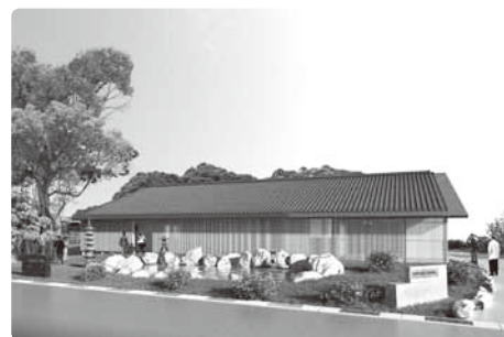
旧津幡小学校跡地に、歴史資料館を建設
