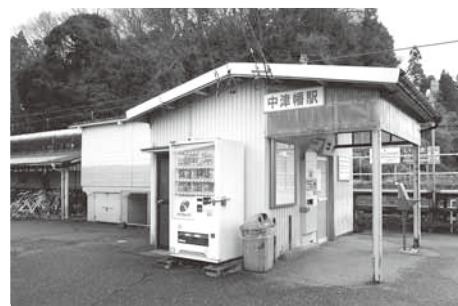
トイレや防犯カメラを新設「中津幡駅前広場」
