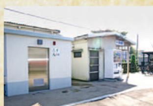
多目的トイレなどを設置「中津幡駅」
