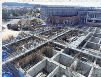
基礎工事 (令和2年2月)
