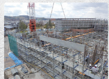
コンクリート梁の設置工事 (令和2年4月)
