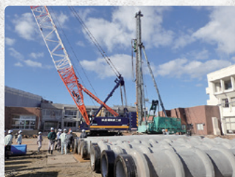
杭工事 (令和元年11月)
