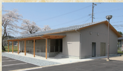
「笠谷地区防災活動拠点施設」を整備
