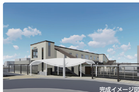
いよいよ工事に着手「津幡駅東口」整備
