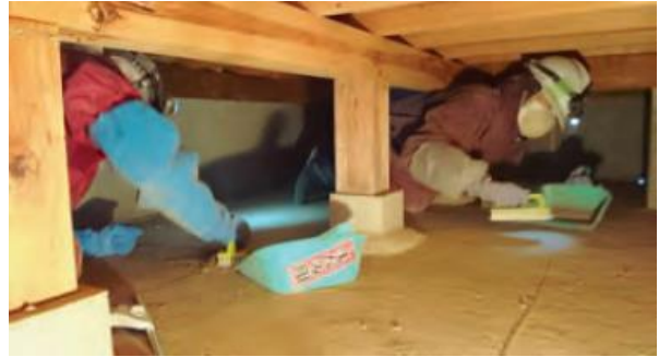
床下に入るときは換気をし、2人以上で作業します。
