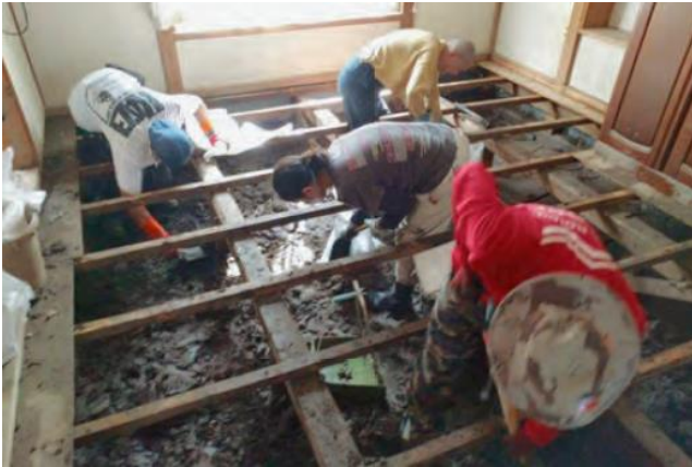
床下に入るときは換気をし、2人以上で作業します。
